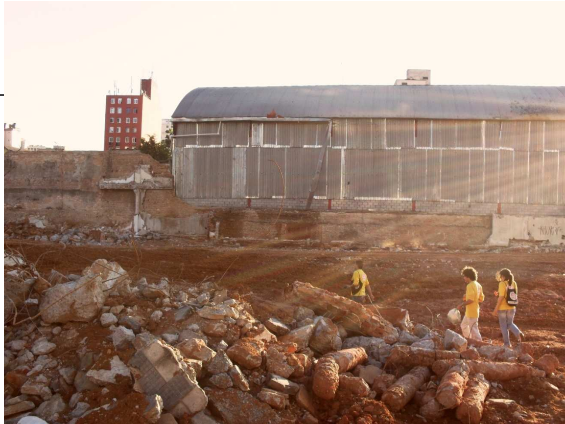
Atuação dos Redutores de Danos nas obras
