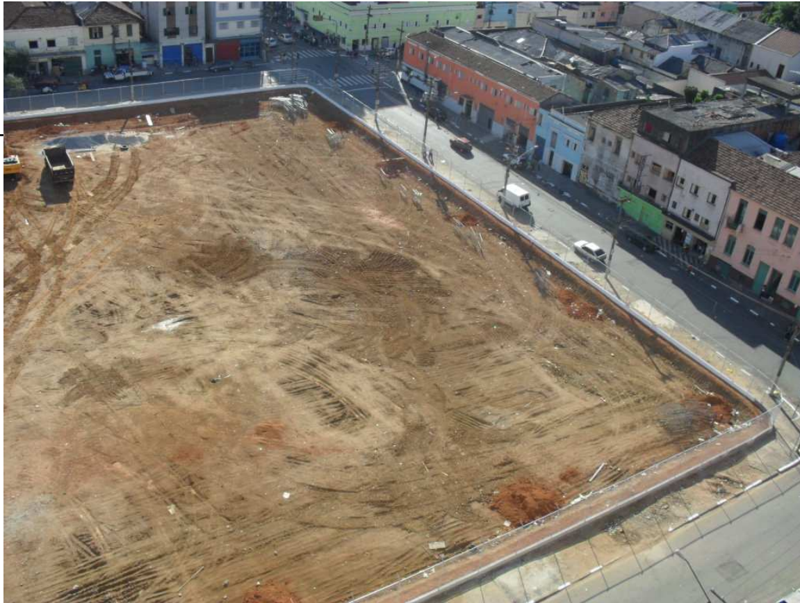
Momento atual das obras
